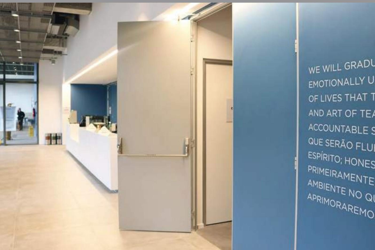
A barra antipânico Metalika garante a saída de pessoas do ambiente a qualquer momento, com o mínimo de esforço físico, independente do uso de chave ou qualquer outro objeto, permitindo dessa forma, uma evasão rápida do ambiente em casos de emergência.
